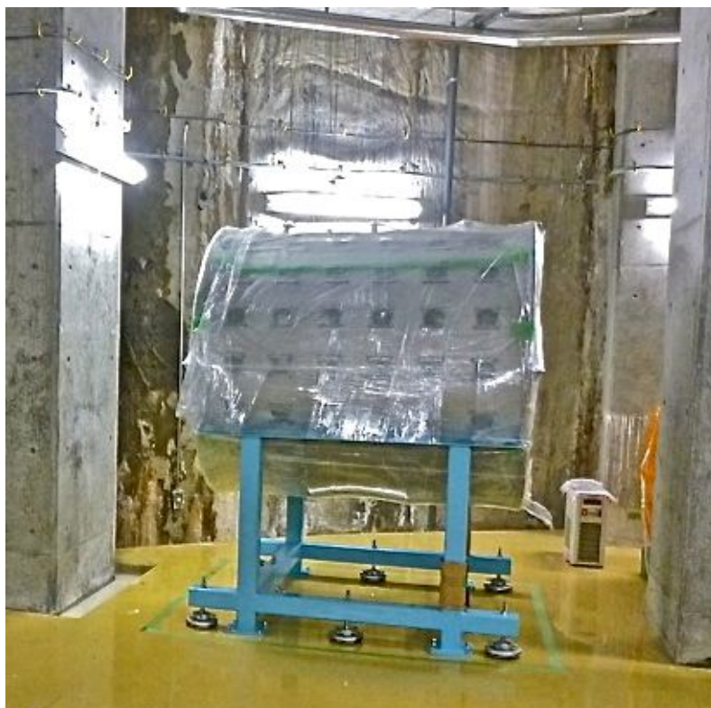
図 3.19: T2K 前置検出器ホール地下 B2 に設置した検出器の写真。
