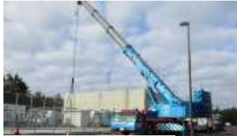
新トランス設置
